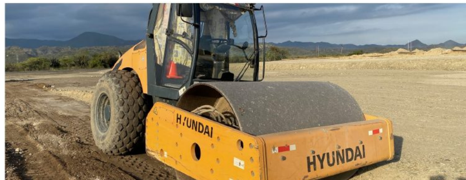
Compactación y conformación
